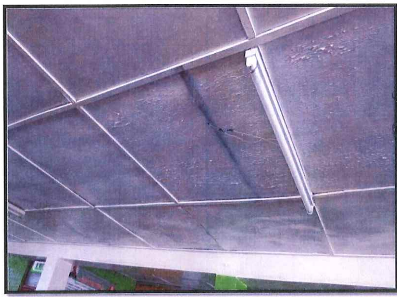
FOTOGRAFIA 94: Se puede observar al interior del comedor como el cielo raso está deteriorado producto de filtraciones y las conexiones eléctricas inseguras.
