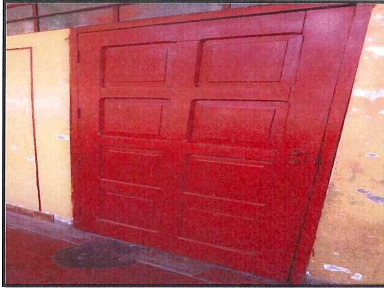
FOTOGRAFIA 55: En la puerta se observa que se encuentra ligeramente descuadrada y que por ello presenta dificultad para abrirla/cerrarla.
