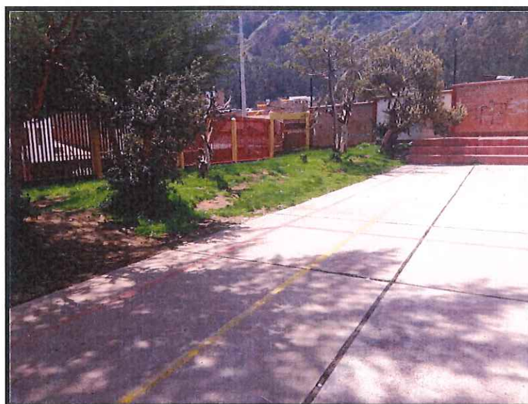
FOTOGRAFIA 112: Se puede observar el área verde con la que cuentan las losas multifuncionales, así como también el poco mantenimiento con la que cuenta.
