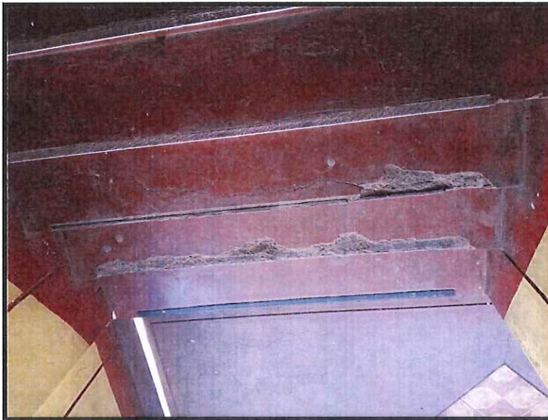
FOTOGRAFIA 48: Se observa que las escaleras tienen muchas grietas.
