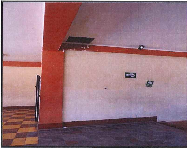
FOTOGRAFIA 75: Se observa los cielos rasos por cierto tramos se encuentran afectados por la humedad.
