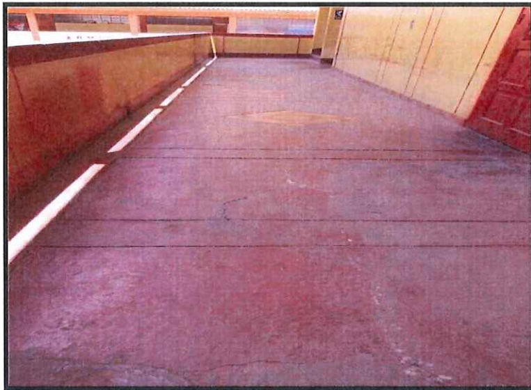
FOTOGRAFIA 74: Se observa el estado en que se encuentran los pisos las grietas que evidencian el desgaste de los mismos.
