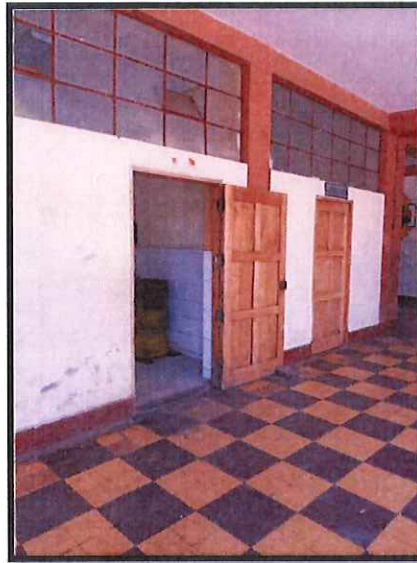
FOTOGRAFIA 37: Se aprecia la entra del servicio higiénico del pabellón de secundaria, así como también el desgaste de la pintura y el contra sòcalo en mal estado.
