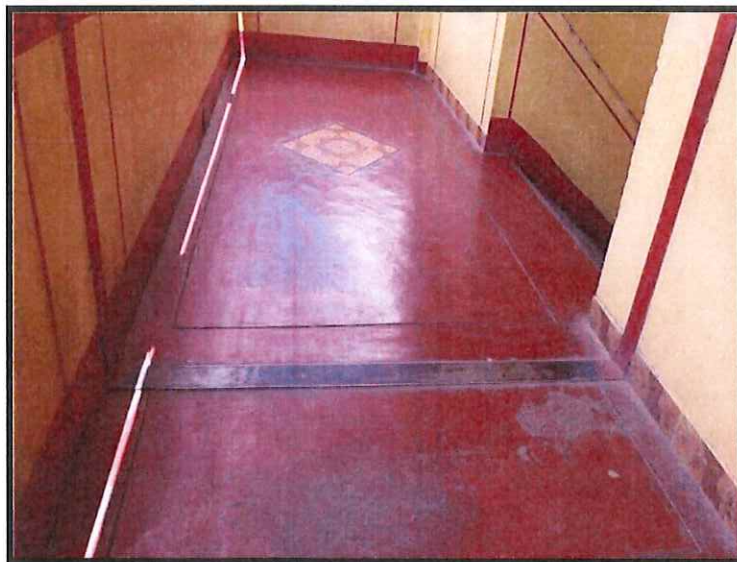
FOTOGRAFIA 54: Se aprecia el grado de deterioro de los pisos, principalmente en los pisos de los corredores ocasionados por la falta de mantenimiento y cuidado.
