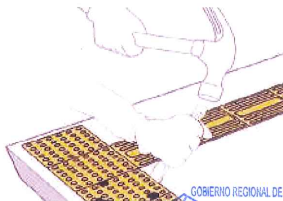
Reposición: Retirar la pieza dañada con un cincel.
