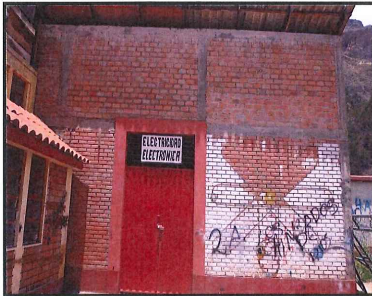
FOTOGRAFIA 92: Se puede observar que el taller de electricidad a diferencia de los otros dos talleres no cuenta con revestimiento (Tarrajeo exterior) debido a que cuenta con tabiquería de ladrillo cara vista.
