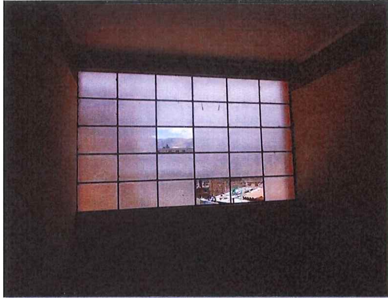
FOTOGRAFIA 77: Se observa el estado de las ventanas, en las que se aprecian ventanas rotas, que requieren ser reemplazadas.
