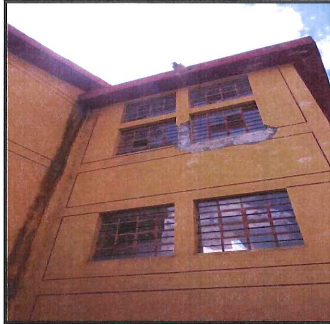
FOTOGRAFIA 53: Se puede apreciar el grado de deterioro del revestimiento de la infraestructura ocasionado por la mala evacuación del desagüe pluvial.
