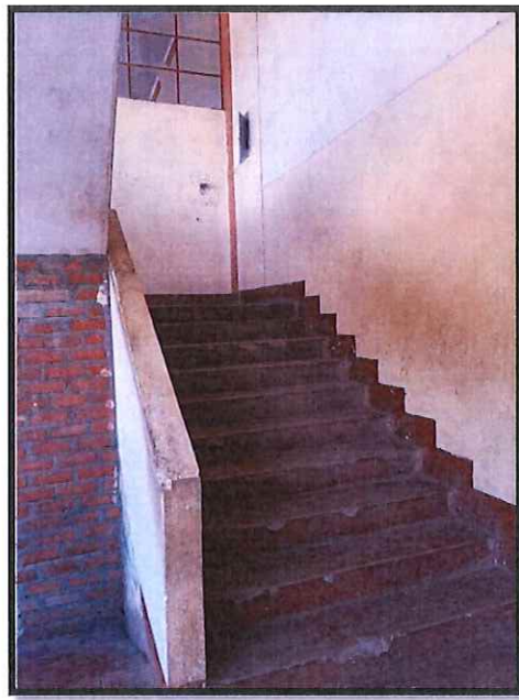
FOTOGRAFIA 71: Se verifica que las escaleras del primer nivel se encuentran desgastadas y quiñadas por el paso del tiempo.
