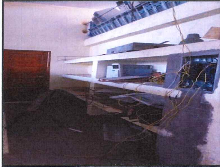
FOTOGRAFIA 91: Se puede observar instalaciones eléctricas precarias e improvisadas al interior del Taller de Mecánica.
