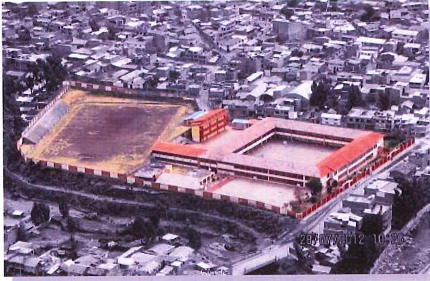
Vista General de la infraestructura actual
