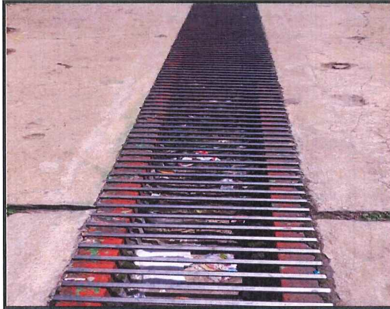
FOTOGRAFIA 60: Se puede apreciar el drenaje pluvial obstruido a falta de un buen mantenimiento.
