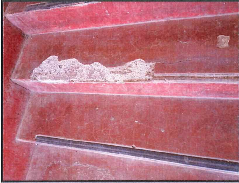
FOTOGRAFIA 47: Se observa el desprendimiento de una esquina de las escaleras.
