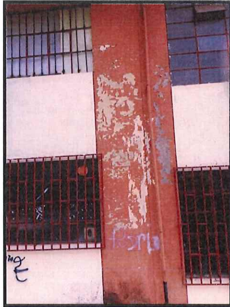
FOTOGRAFIA 73: Se observa el desprendimiento de la pintura causado por la humedad y el desgaste de las rejillas de las ventanas.
