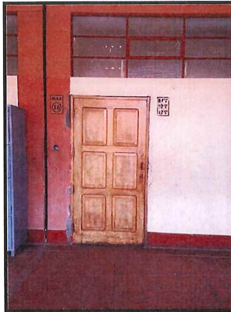
FOTOGRAFIA 27: Se observa el aula 16 con la puerta descuadrada así como también el desgaste de las columnas.
