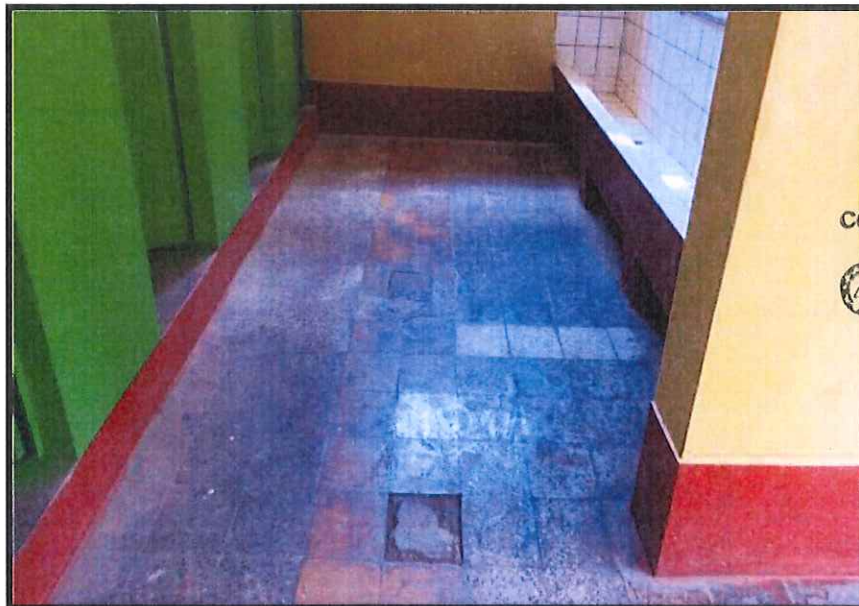
FOTOGRAFIA 64: Vista del deterioro de los pisos por la humedad y acumulación de agua, causado por la obstrucción de las tuberías de desagüe.
