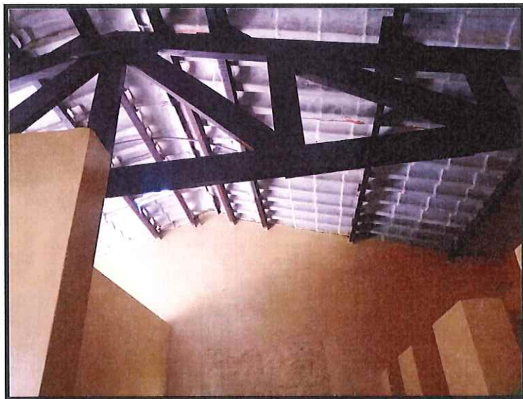
FOTOGRAFIA 68: Se observa las vigas de madera del techo del servicio higiénico de primaria.
